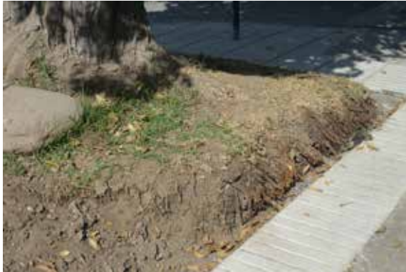
Figura 12: Corte drástico de raíces para confinarlas durante el proceso de mejora de veredas.
